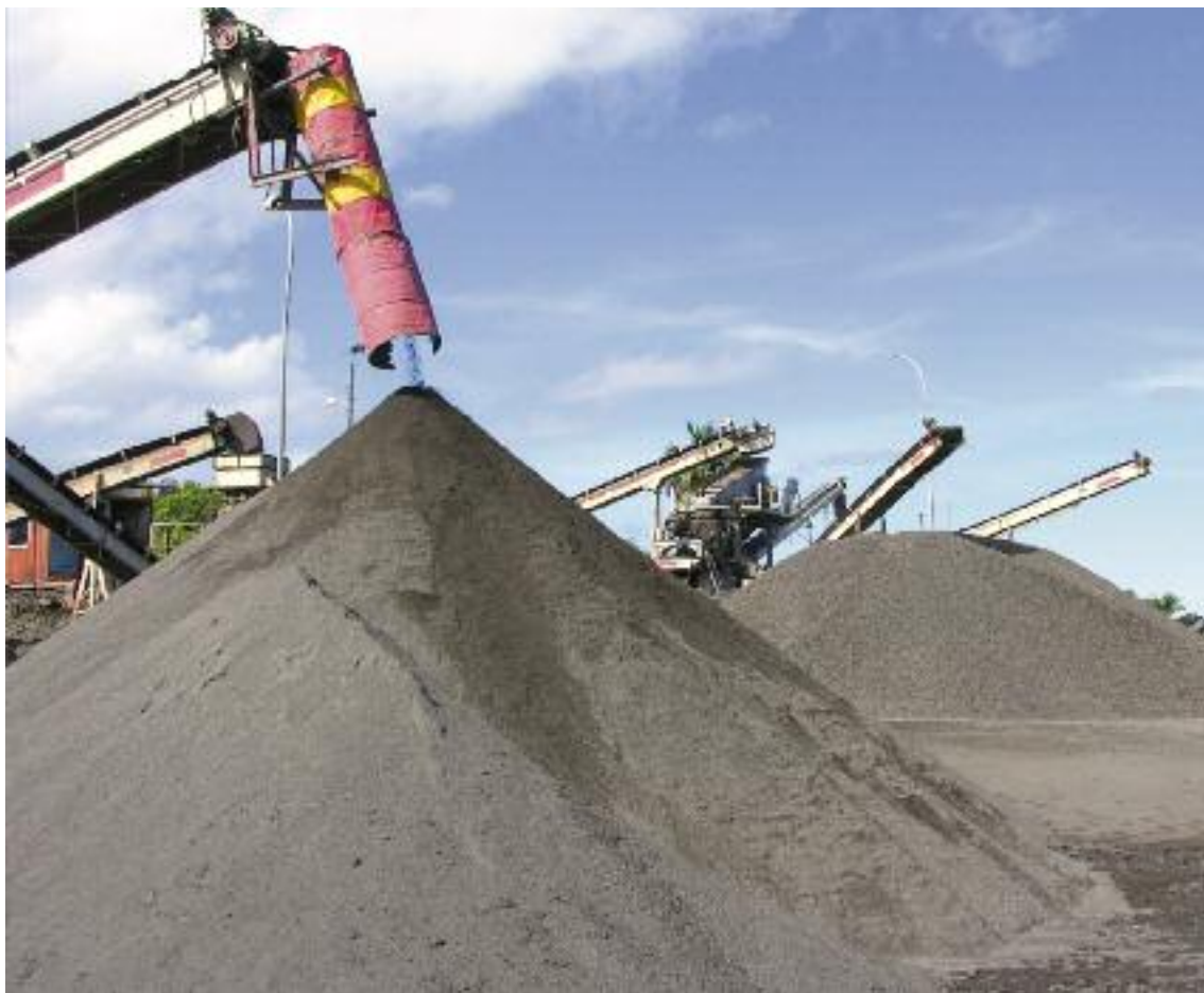
Site de concassage à Oussivo.
